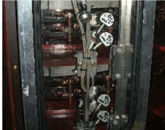
Abbildung 5.13-1: Pyrometer und Luftfeuchtigkeitssensor an Schleifringen
