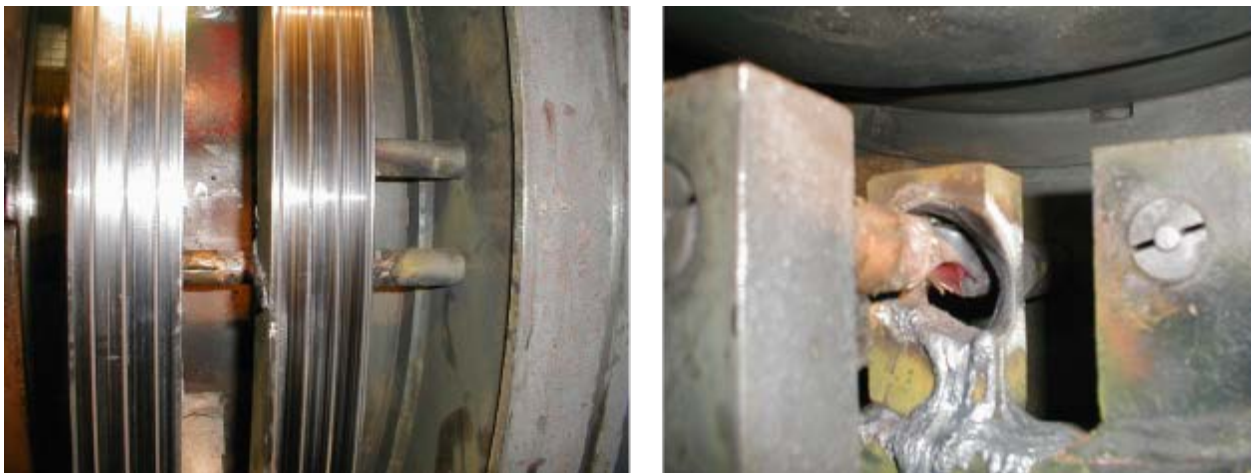
Abbildung 6.6-4: Kurzschlusschaden an einer Erregerzuleitung durch Versagen der Isolierung am Durchtritt der Erregerzuleitung durch den Schleifring
