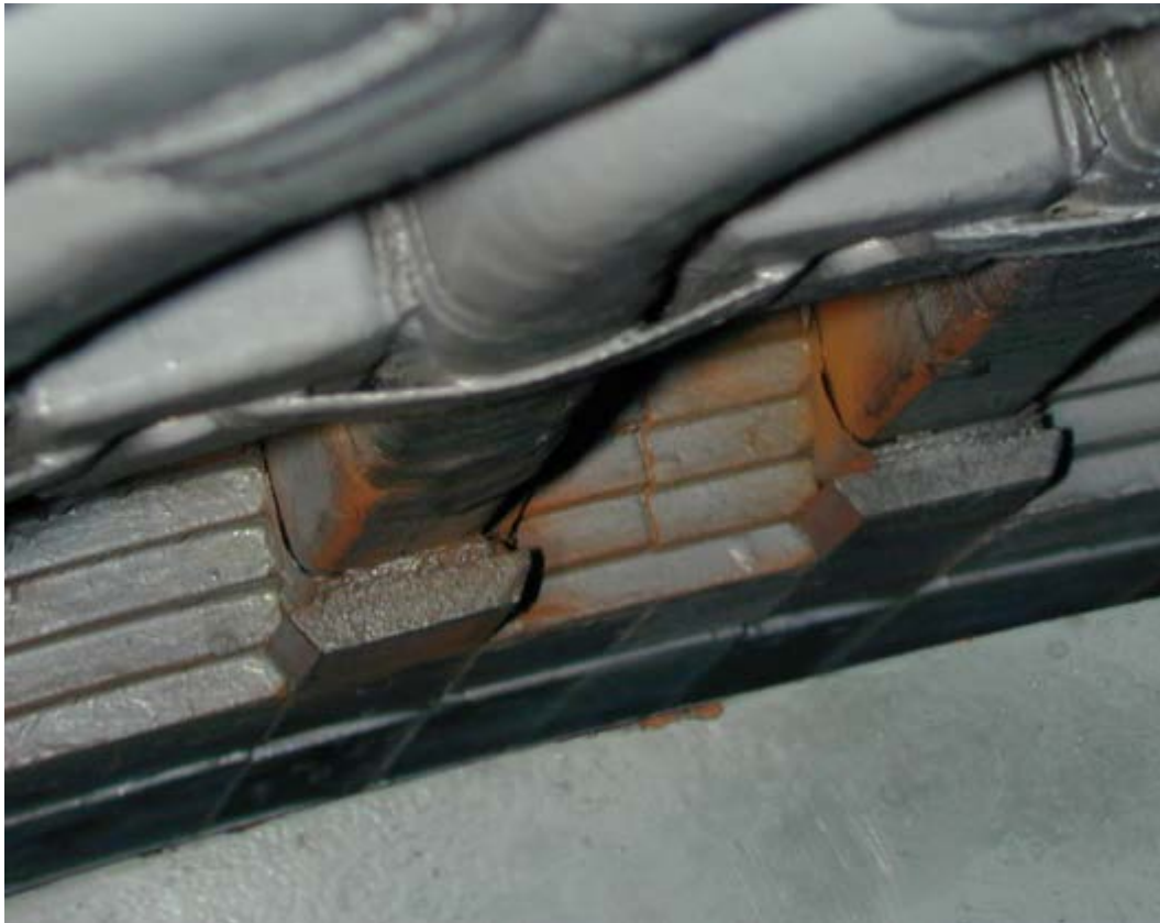
Abbildung 6.4-1: Beginnende Lockerung, Reibstaub
