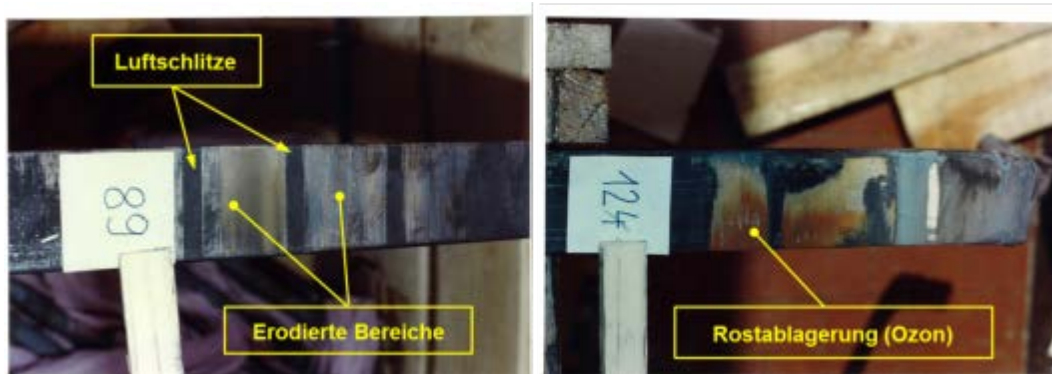
Abbildung 6.2-3: Fortgeschrittene AGS-Beschädigung durch Stabvibrationen (Abrieb) und TE-Erosion infolge schlechter Verteilung
