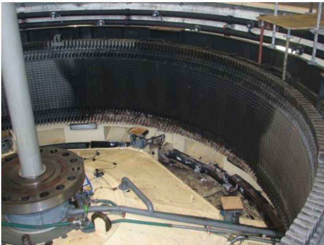
Abbildung 6.5-1: Brandschaden durch überhitzte Weichlotverbindung
