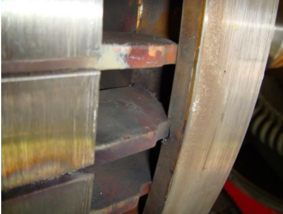
Abbildung 6.8-1: Kurzschlussläufer, gebrochener/ausgelöteter Käfigstab
