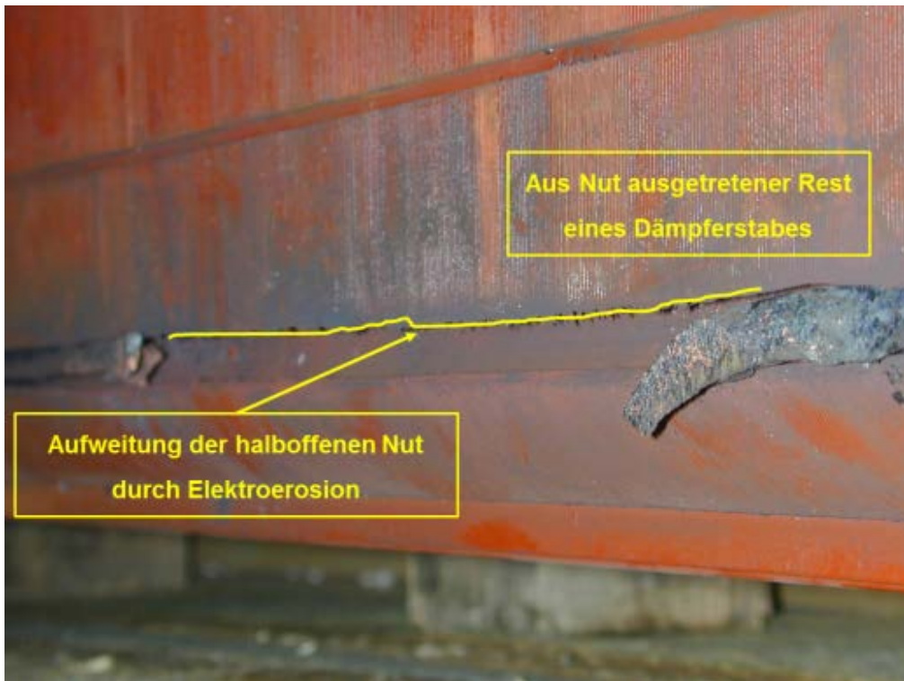
Abbildung 6.7-1: Schäden an Polen und Dämpferstäben
