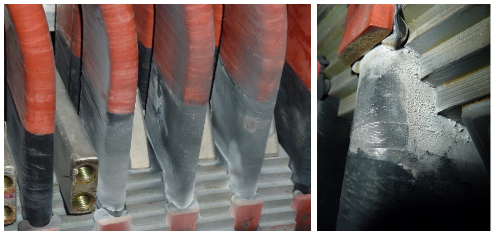
Abbildung 5.1-8: 18-kV-Statorwicklung mit AGS-Erosionen am Nutaustritt einiger Wicklungsstäbe. Das schwarze AGS-Band ist lokal durch den TE-Angriff zersetzt
