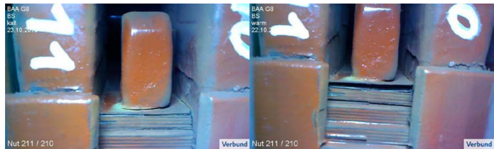
Abbildung 5.14-4: Vergleich einer Schadenstelle bei kaltem bzw. warmem Blechpaket (Buckling Visualization System, Verbund Hydro Power GmbH)
