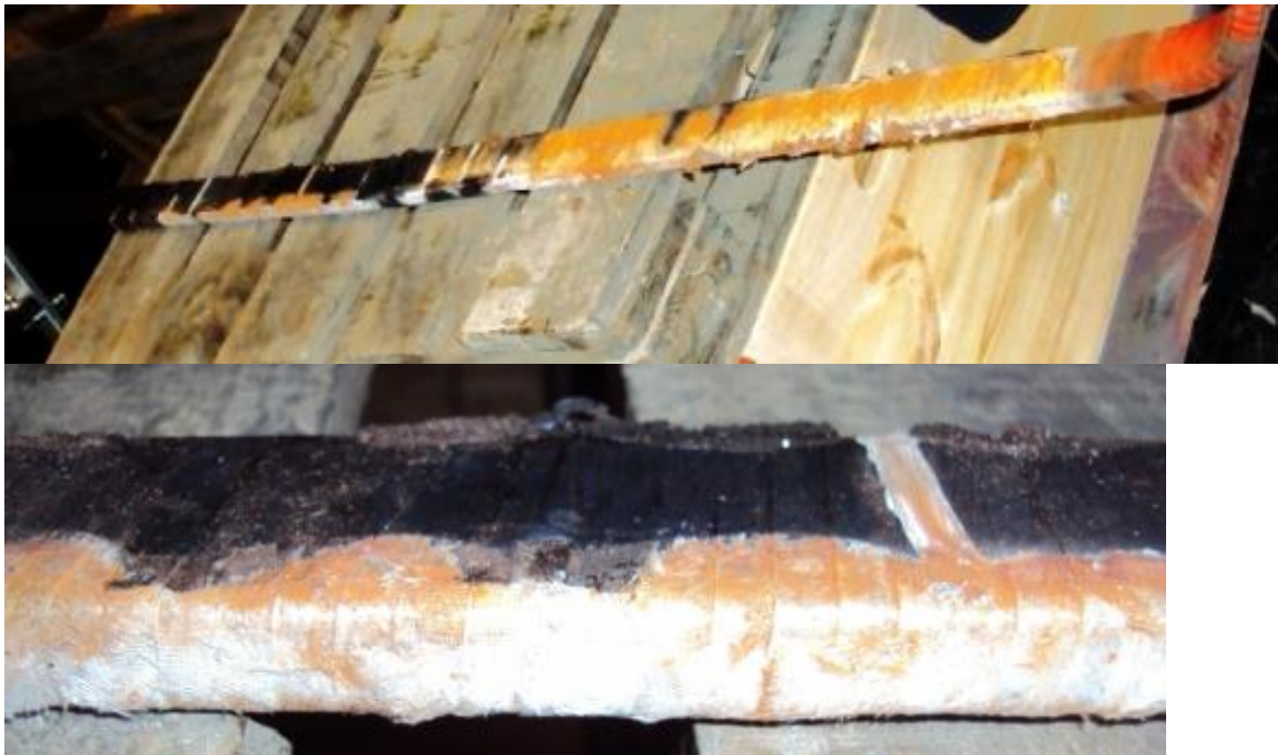
Abbildung 6.3-4: Fortgeschrittene AGS-Schäden im Nutbereich durch TE-Erosion
