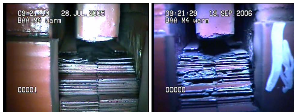
Abbildung 5.14-3: Schädigungsfortschritt eines gelockerten Endblechsegment im Zeitraum eines Jahres (aufgenommen mit dem Kamerasystem von Andritz Hydro GmbH)
